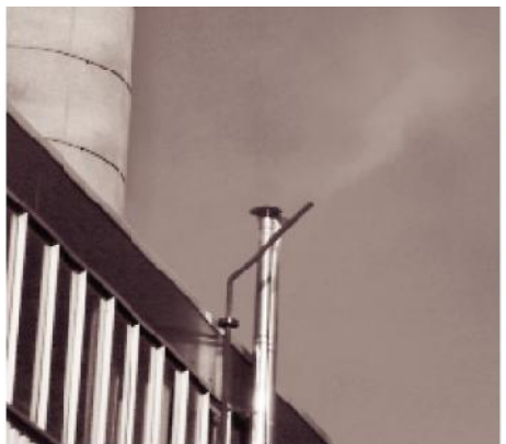
DESPUÉS DE INSTALAR TRAMPAS GEM
